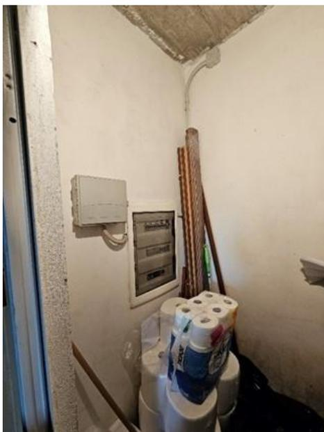
*Figura 47 – Quadro elettrico di appartamento (QEA) esistente in locale tecnico*
