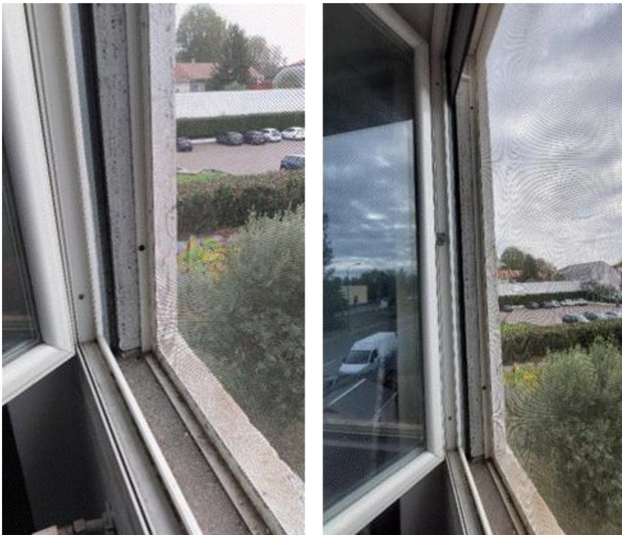
*Figura 11 – Finestre del primo piano con zanzariera e avvolgibili*
